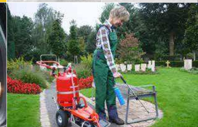
Mit dem Handbrenner können auch schwer zugängliche Stellen bearbeitet werden.
