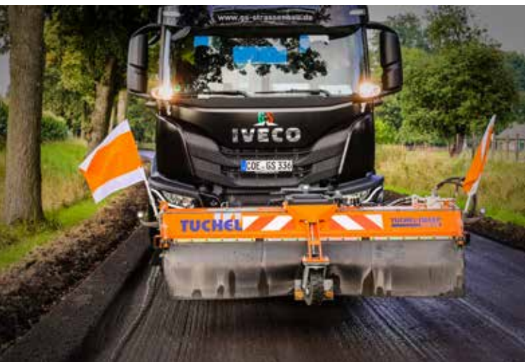
Seitenverschiebung am Unimoganbau
