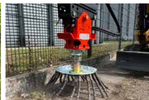
Steigerung der Flächenleistung durch Verschwenken des Baggers
